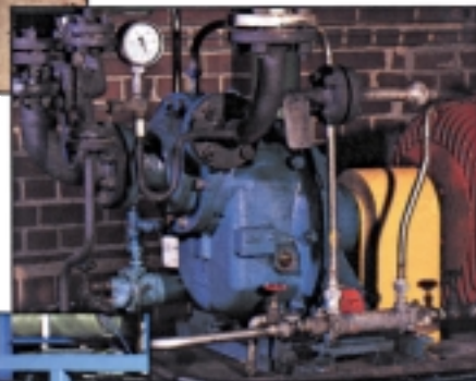
Sunflo P-3000 en una aplicación de alimentación de caldera.
