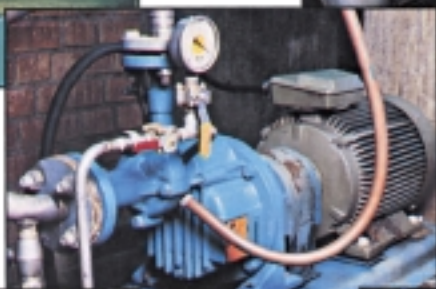
Sunflo P-1000 como ejemplo de bomba de toma de muestras.
